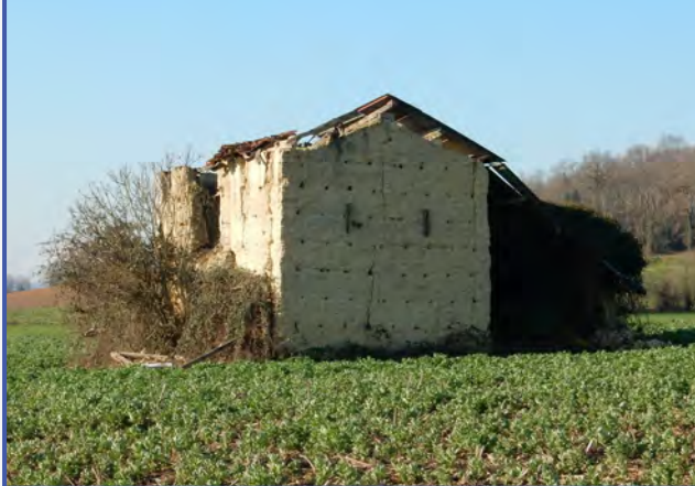
Bâti ancien abandonné (quartier Lantonies)
